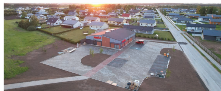
Ehitamisel arvestati kõrvalasuvate elamute paiknemisega ning kaubandushoone kavandati krundile viisil, et see moodustaks mürapuhvri maantee ja eluhoonete vahele.
