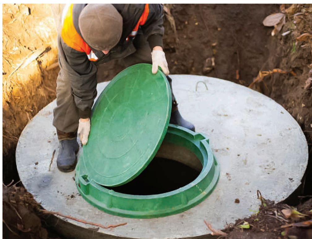
Kurepalu ühisveevärgi- ja kanalisatsioonisüsteemi rajamine.
